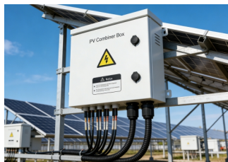
PV String Boxes
